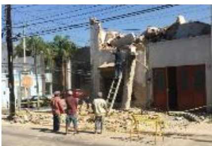
Figuras 19, 20 y 21. Inmuebles en evidente estado de abandono
